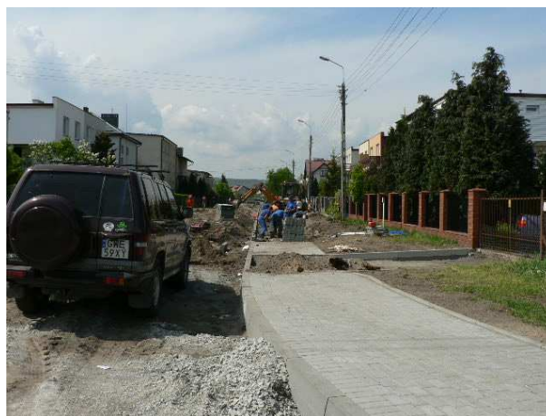
Budowa ulicy Okrzei
