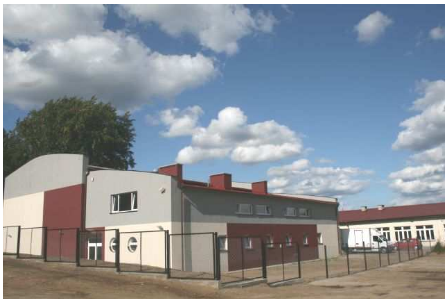
Sala gimnastyczna przy SP6 - wartość inwestycji 2 mln. 314 tys. zł
