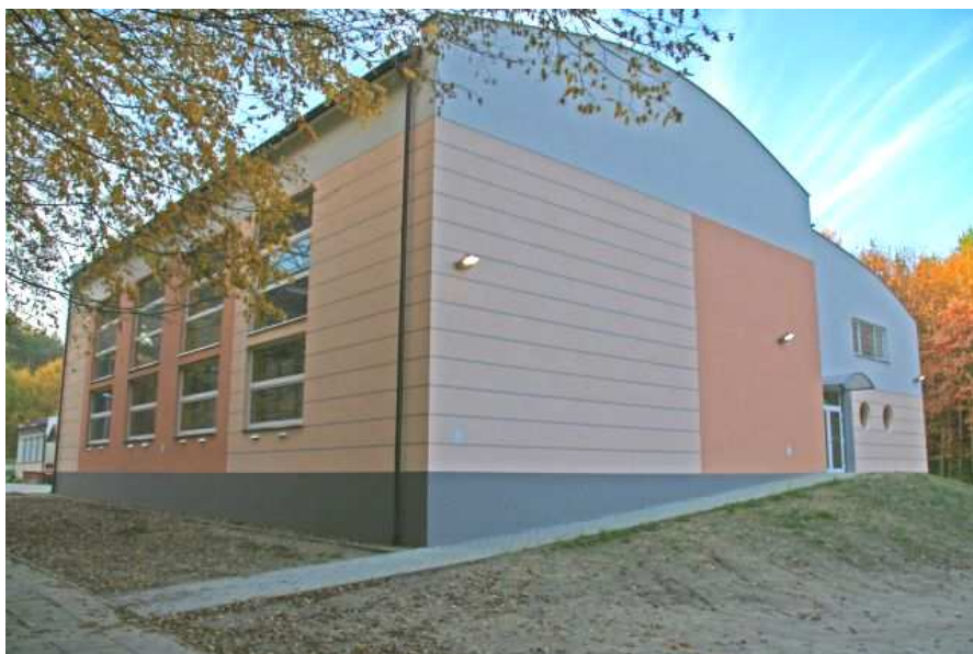
Sala gimnastyczna przy SP5 - wartość inwestycji 2 mln 570 tys. zł
